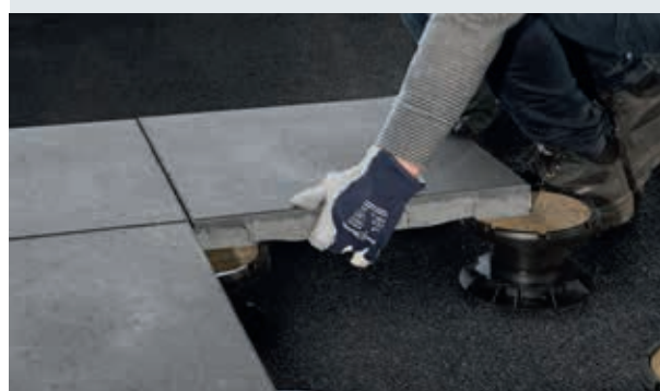
Dreen®Nxt è dotato di incavo sul lato inferiore, in cui si inserisce con precisione la piastra bloccante
